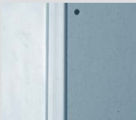
4. Knauf ploče se montiraju s razmakom od 5 mm prema traci
