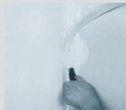
6. Nakon sušenja treba odrezati višak razdjelne trake
