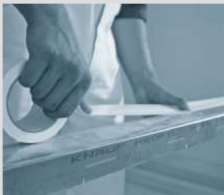
1. Samoljepiva Trenn-Fix traka se pritisne za CW/UW ili UD profil
