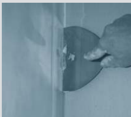
5. Nakon montaže ploča zapunjava i izravnava se spoj
